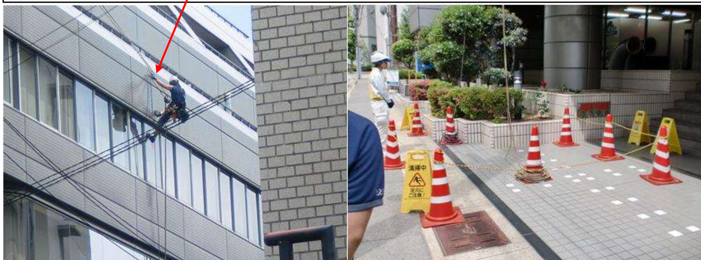
玄関前で監視員が配置されていた。○
